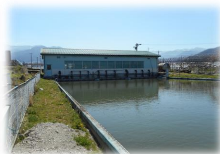
竹原揚水機場
